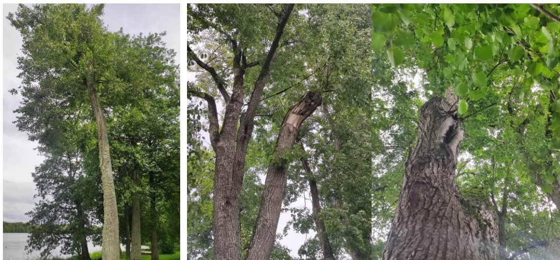
15 pav. Trakų m. Liepų alėjos kamienų pažeidimai
