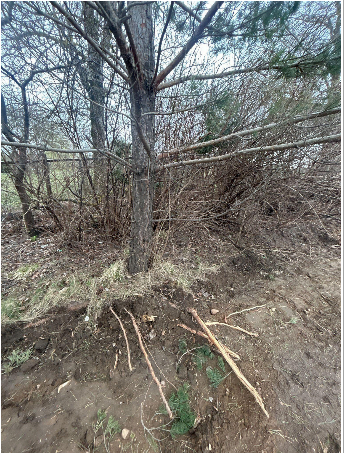
Paprastoji pušis (nr. 59 plane) - šaknynas pažeistas arti kamieno, stipriai sumažėjęs medžio stabilumas. Rekomenduojama atlikinėti kasmetinį būklės monitoringą.
