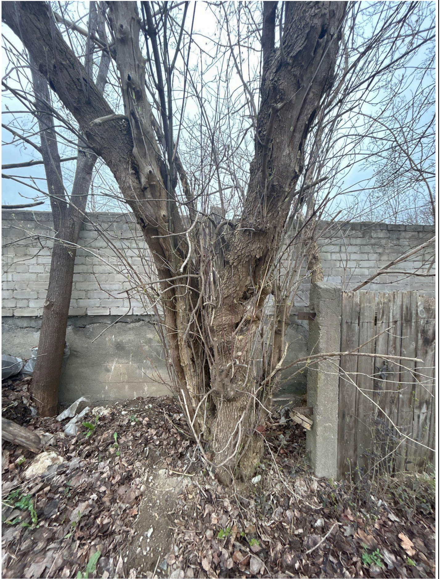
Uosialapis klevas (nr. 39 plane) - auga šalia tvoros pamato, kamiene daug pažeidimų ir trūkių, siūloma šalinti kaip neperspektyvų.
