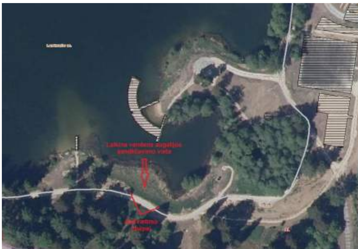
7.27 pav. Inžinerinė infrastruktūra greta laikinos vandens augalijos sandėliavimo vietos Nr. 5
