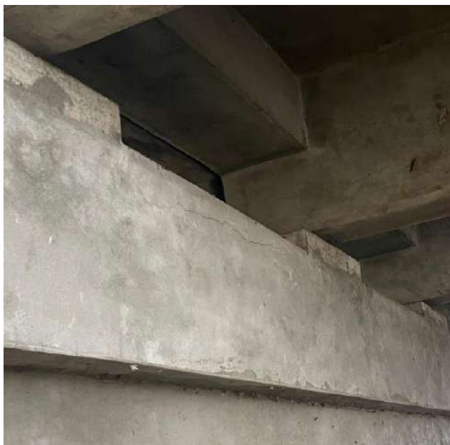
14 pav. Tarpinėse atramose susiformavę įtrūkiai
