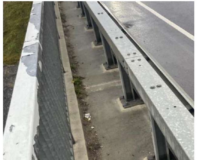
9 pav. Vietomis turėkluose atsilupęs dažų sluoksnis
