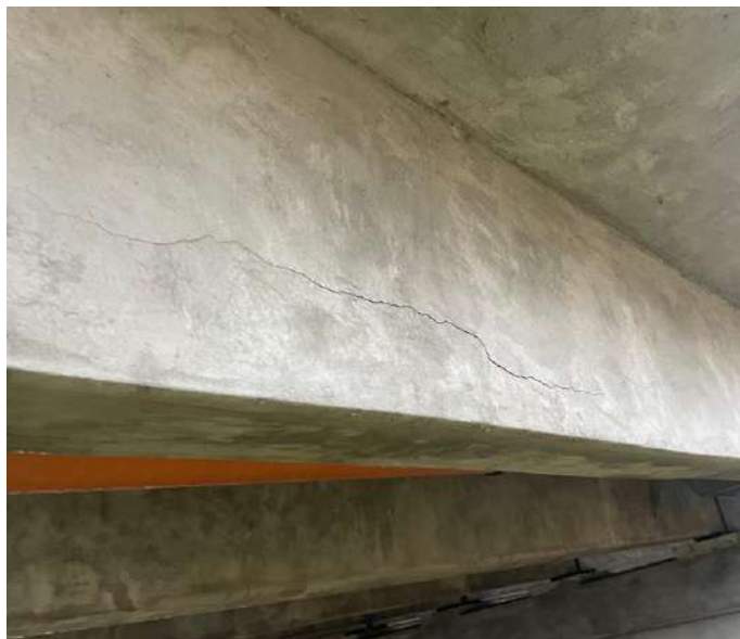
11 pav. Atsivėrę išilginiai plyšiai sijose
