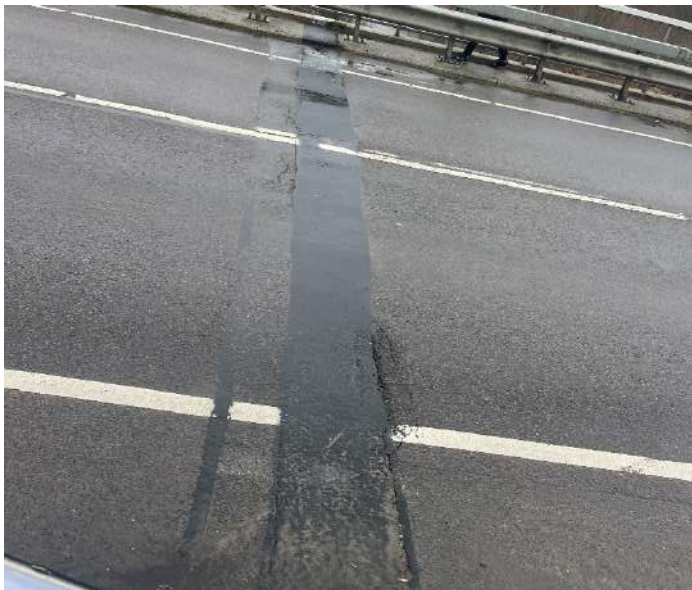
7 pav. Atsivėrę įtrūkiai dangoje ties deformaciniais pjūviais, susiformavusios įdubos
