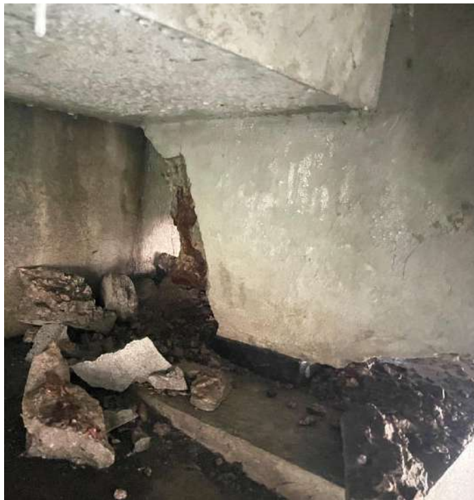
12 pav. Sijų galuose ties atramomis ištrupėjęs betonas, koroduoja armatūra
