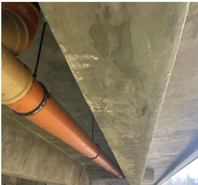
11 pav. Atsivėrę išilginiai plyšiai sijose
