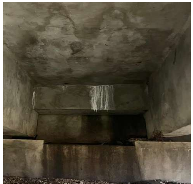
10 pav. Hidroizoliacija nesandari, drėkinama visa perdangos konstrukcija, ties krantinėmis atramomis matomi paplovimai – susidarę kalcio karbonatai
