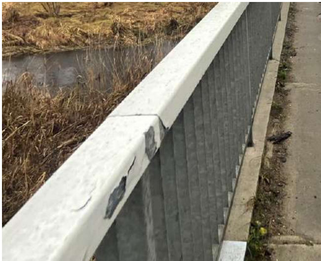
9 pav. Vietomis turėkluose atsilupęs dažų sluoksnis
