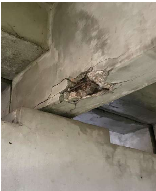
12 pav. Sijų galuose ties atramomis ištrupėjęs betonas, koroduoja armatūra
