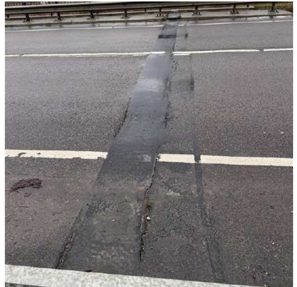
7 pav. Atsivėrę įtrūkiai dangoje ties deformaciniais pjūviais, susiformavusios įdubos
