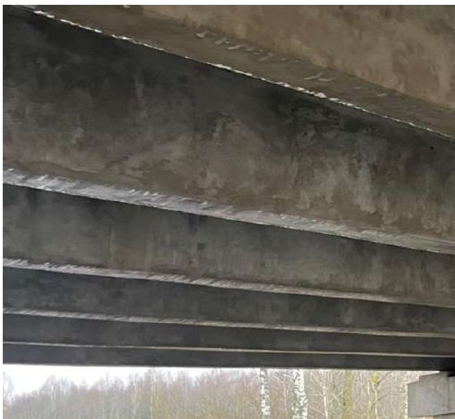
10 pav. Hidroizoliacija nesandari, drėkinama visa perdangos konstrukcija, ties krantinėmis atramomis matomi paplovimai – susidarę kalcio karbonatai
