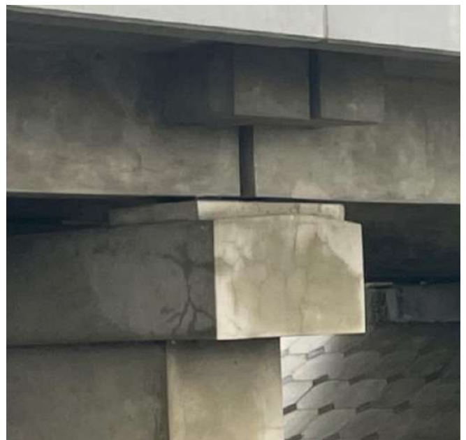
14 pav. Tarpinėse atramose susiformavę įtrūkiai
